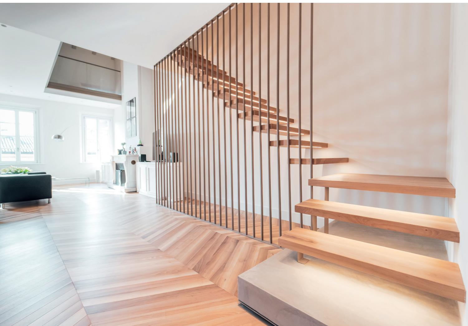
Scala a sbalzo, con gradini fissati direttamente a muro e ringhiera a colonne verticali fissate a soffitto.
