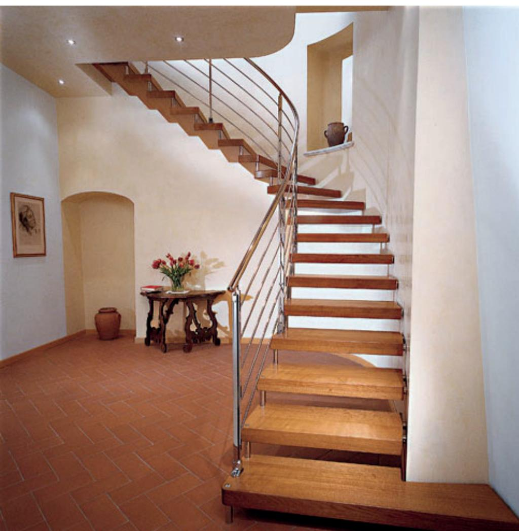
Scala a sbalzo con gradini fissati direttamente a muro e ringhiera in acciaio inox con sistema elicoidale
