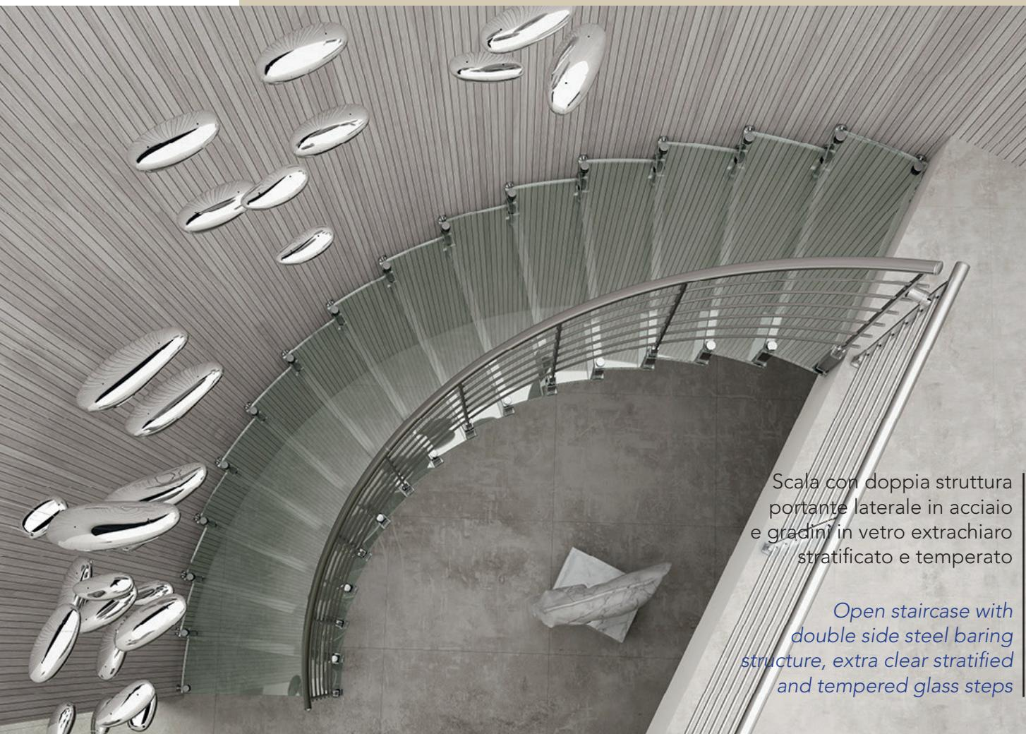
Scala con doppia struttura portante laterale in acciaio e gradini in vetro extrachiaro stratificato e temperato
