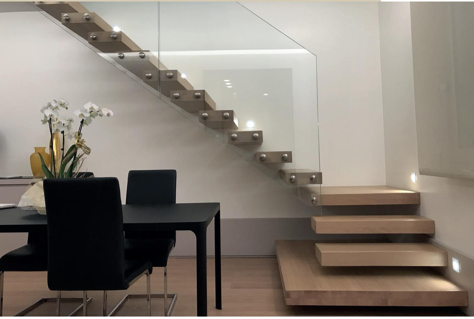
Scala a sbalzo con gradini da 60 / 80 mm fissati direttamente al muro e ringhiera in vetro.
